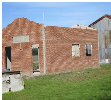
Construcción Comedor Comunitario
